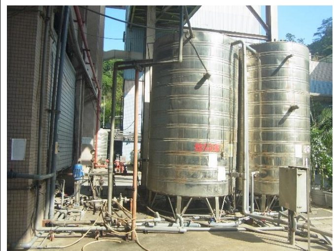
圖 3. 利用收集雨水與山泉水做為工廠部分取代自來水用水
