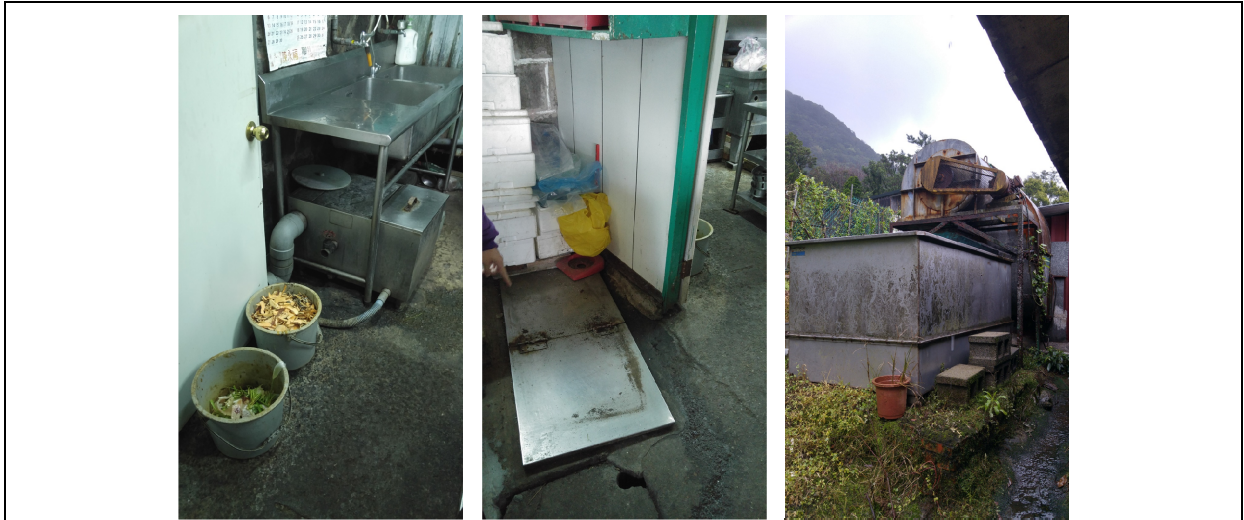
「竹子湖炒青菜」：為國有地承租戶，有設置廚房油污水及油煙排放之處理設備
