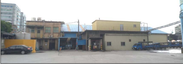
① 基地西北側現況
