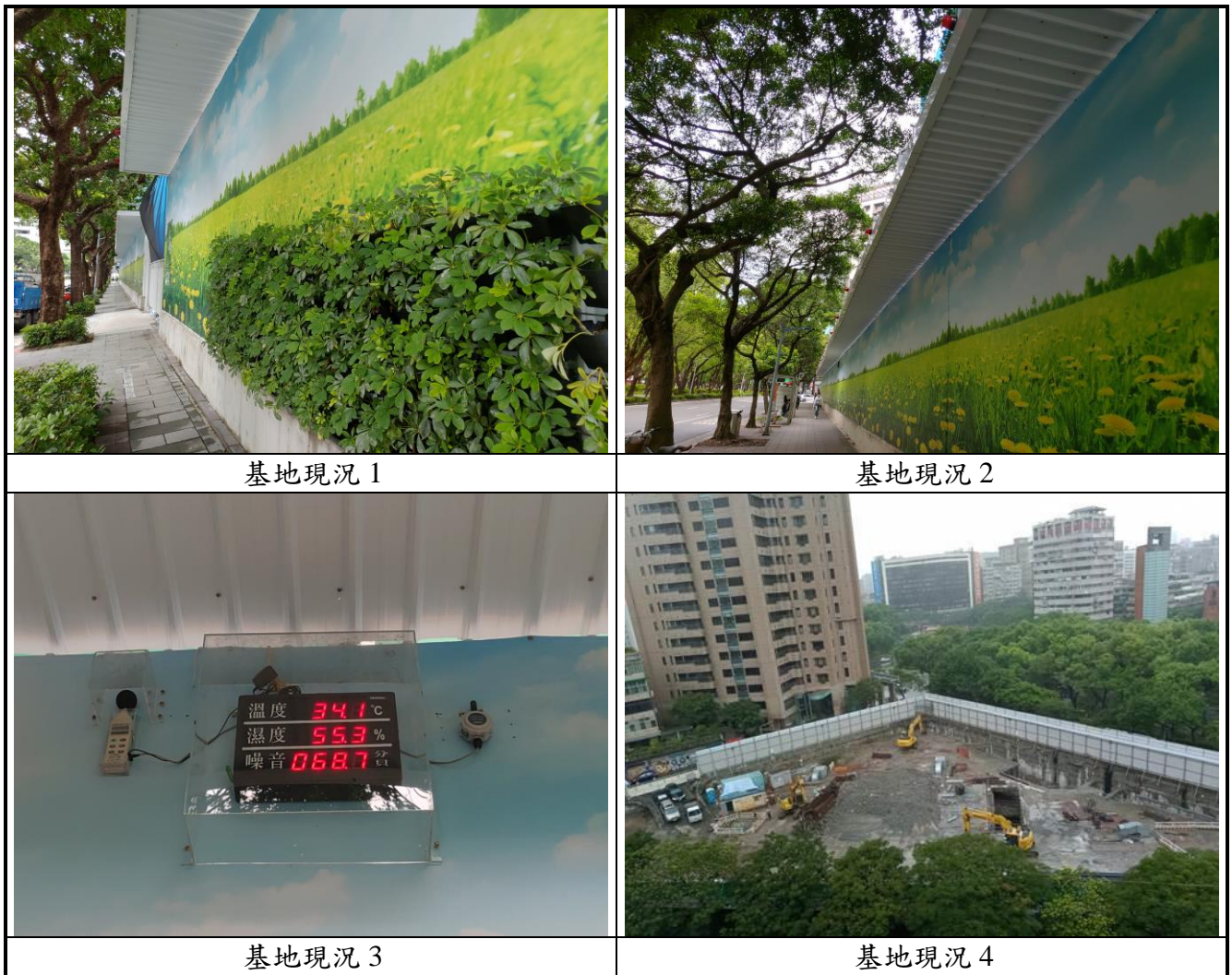
圖3-1 基地現況照片
