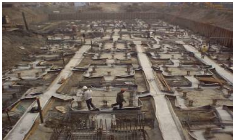
CL700B區段標之CL805標蘆洲機廠主變電站基礎鋼筋組立
