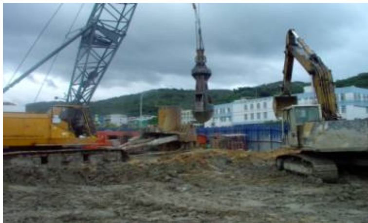
B2車站試樁樁體施作
