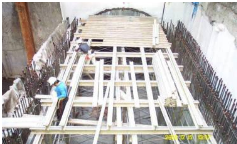
CD550標捷運CP265C標板橋站工作井頂版支撐架組立施作
