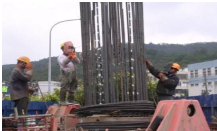
B2車站試樁鋼筋籠搭接
