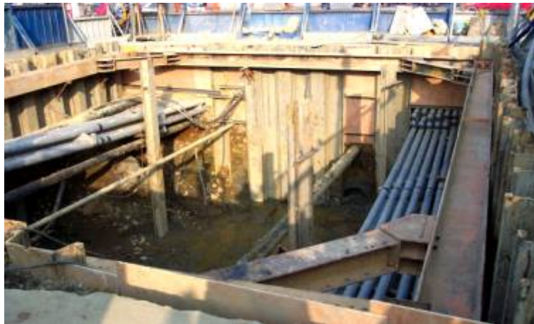
CK570E隧道聯絡通道地盤改良及管線吊掛保護
