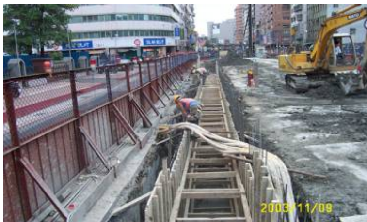
CK570C菜寮站連續壁導溝施作情形
