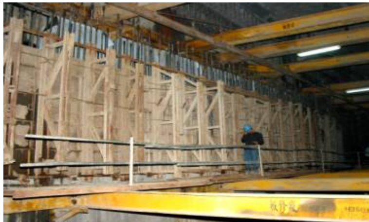
土城線CD551永寧站月台層側牆施作情形
