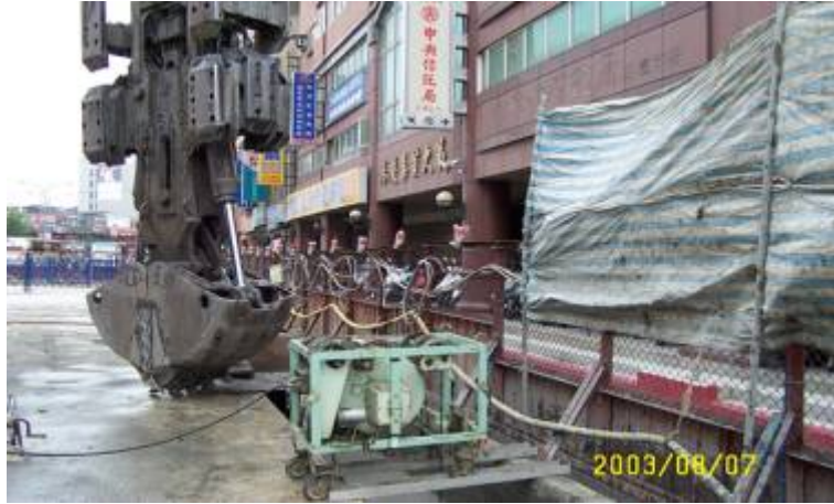
570C菜寮站連續壁之超音波測試情形
