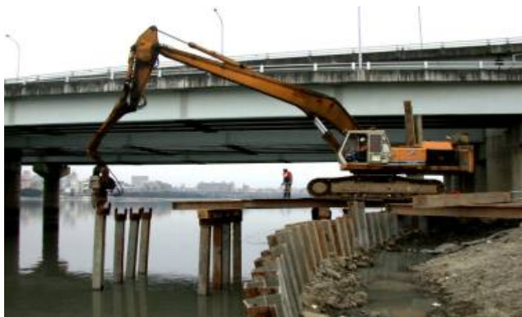
CK570C過河段圍堰構台打設情形
