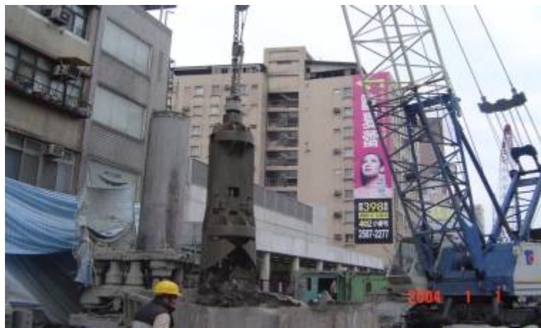
新莊線CK570B民權西路站切削樁抓掘出土
