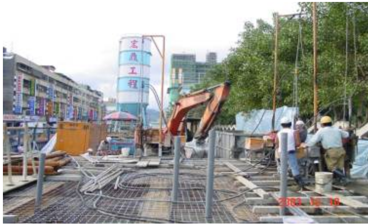
CL700B區段標之CL803標三民高中站站體西側潛盾第二到達井地改JSG灌漿作業
