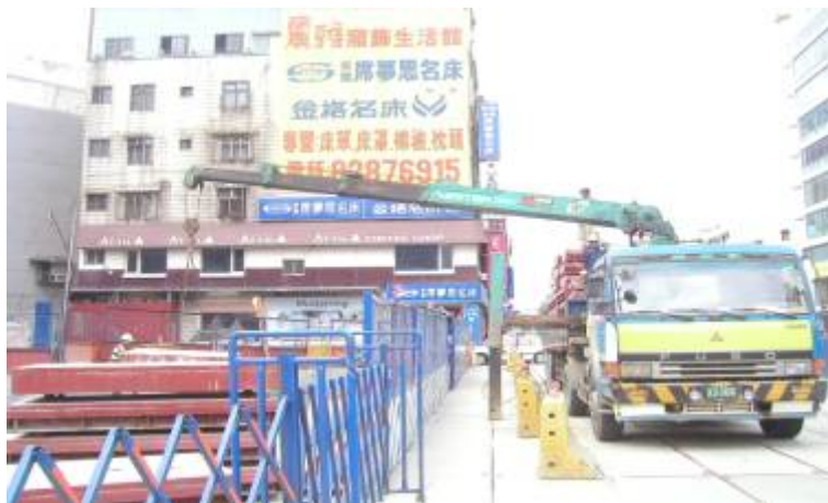
CL700A區段標之CL801標三和國中站覆工鉸吊放作業
