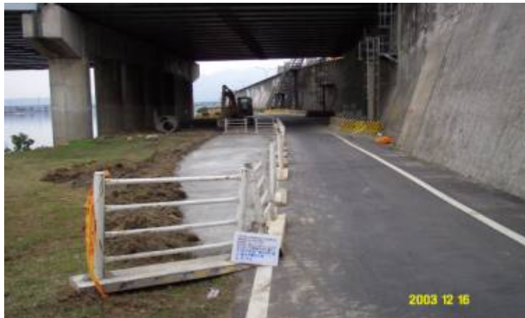
新莊線CK570G大橋國小站堤外平衡池施工便道
