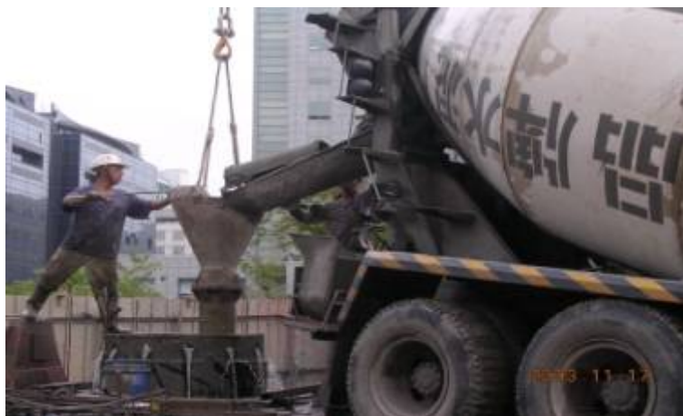
CB423標BSS(主變電站) 混凝土澆置
