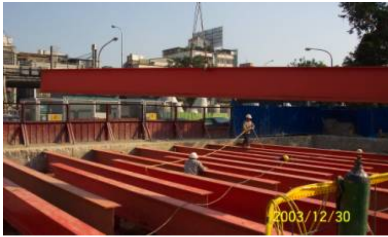
新莊線CK570B中山國小站覆工版系統覆工樑架設
