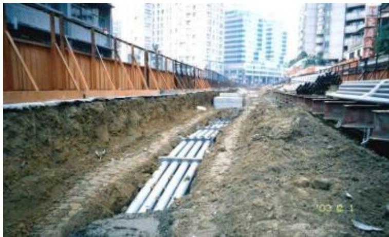
CD550區段標之CD266標明挖段南雅南路中間帶電力管道埋設施作
