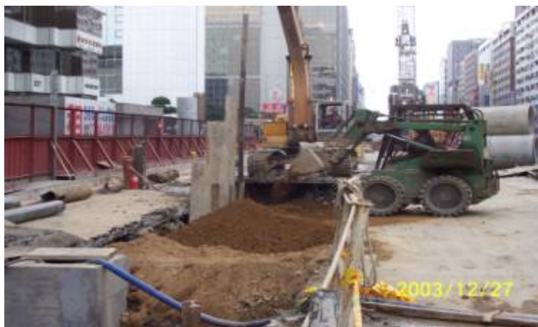
新莊線CK570B行天宮站涵管埋設級配料回填
