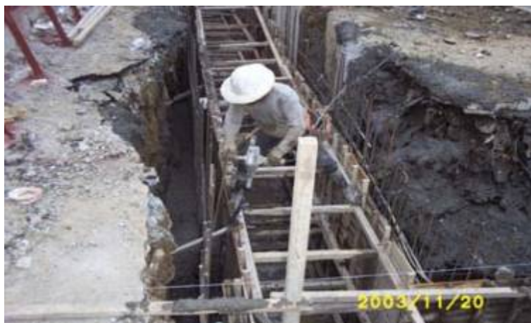
CB410區段標工區連續壁導溝施作
