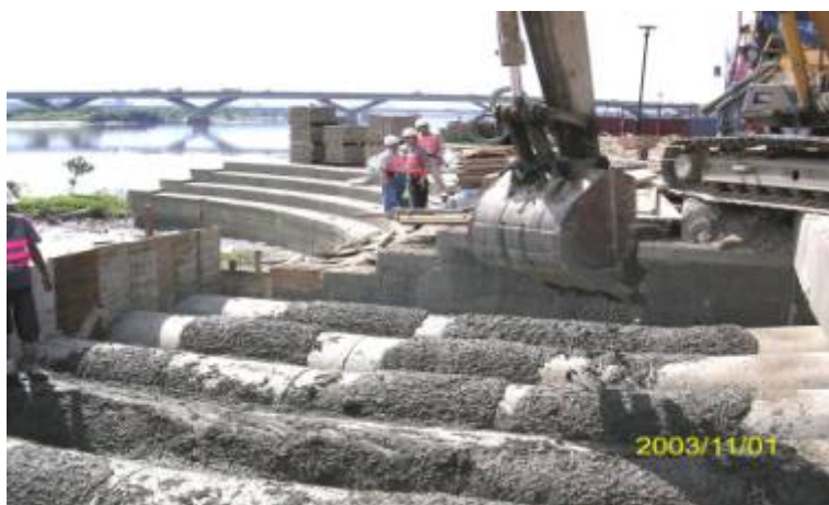
CK570C同安抽水站提外施工情形
