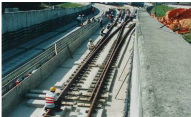
CD550區段標捷運CD511標土城機廠出土段特殊軌T59示範段組裝查核
