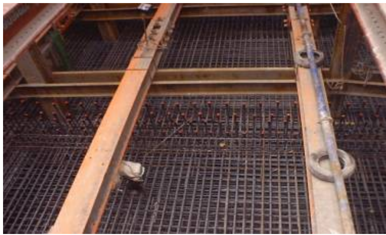
CL700B區段標之CL804標蘆洲站站體底板鋼筋綁紮
