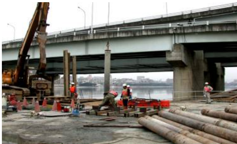
CK570C連續壁密特管打設情形
