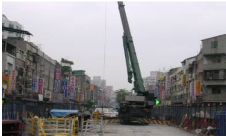
CL700A區段標之CL800標三重國小站站體支撐吊放
