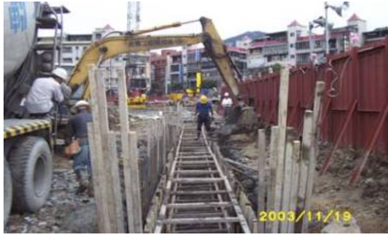
CB410區段標工區連續壁導溝施作
