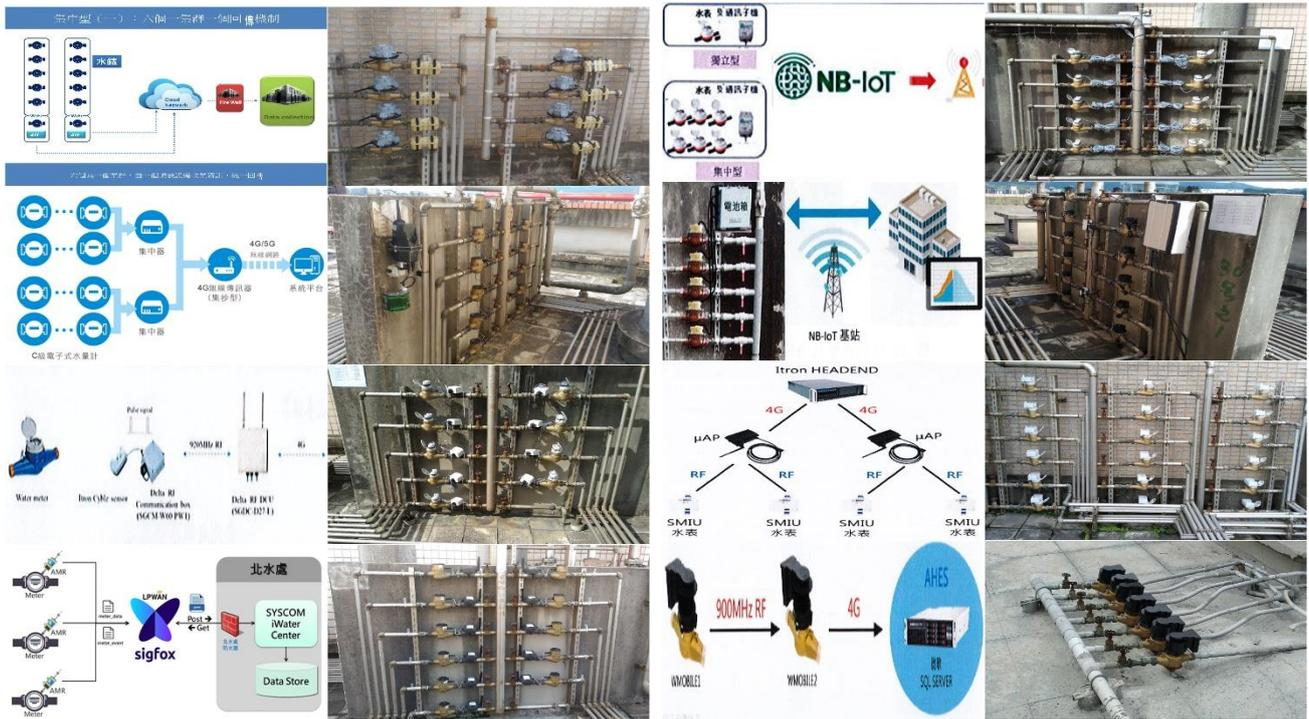
智慧水表依讀表的方式，分為數位訊號、脈衝訊號以及影像辨識等3種類型的智慧水表，可採用4G、NB-IoT、WiFi、固網傳輸或其他有線或無線等方式，進行讀表及回傳用水資料。
