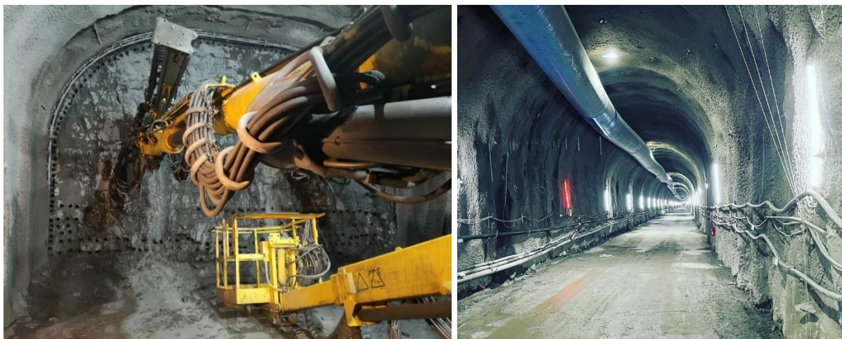
主線隧道開挖施工情形
