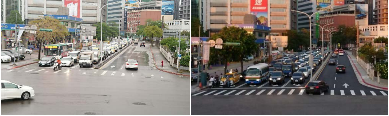
圖 5 港墘路西側道路由 3 車道(左)拓寬為 4 車道(右)
