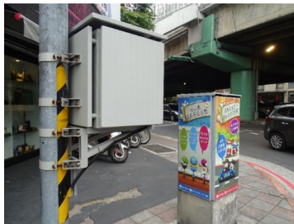
圖 11 號誌不斷電系統(左)與控制器(右)
