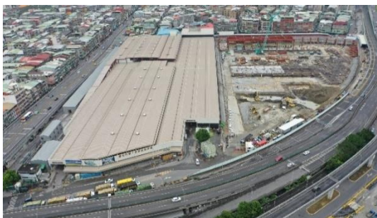
主體工程施工現況
