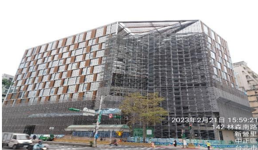
南門市場現場施工照片
