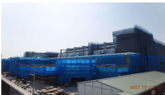
環南市場第2期工程現況
