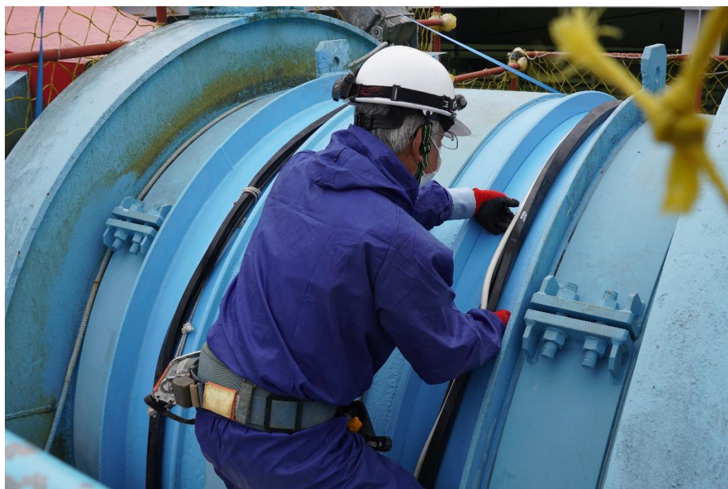
永福水管橋更換止水膠圈
