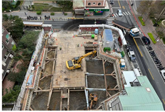
臺北市立圖書館康寧分館合署大樓新建工程施工現況
