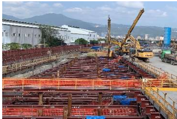
環狀線北環段 CF680C 區段標北機廠開挖支撐施工現況
