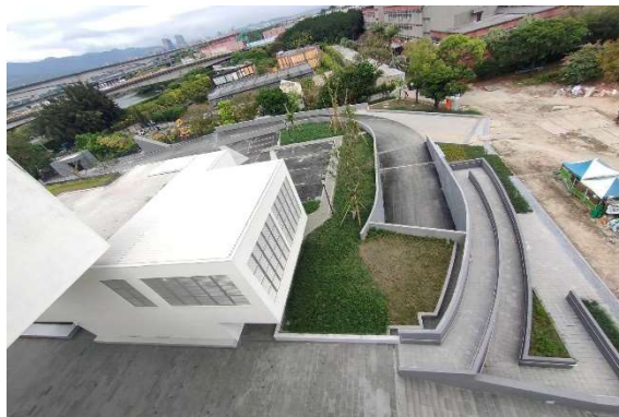
臺北市立美術館典藏庫房新建暨南進門改善統包工程完工現況
