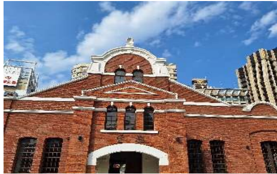
市定古蹟臺北工場修復工程完工現況
