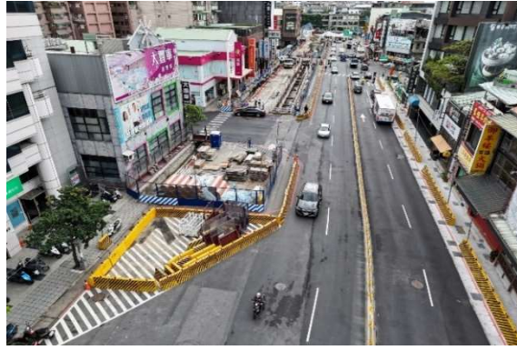
環狀線北環段 CF680B 區段標- Y21 站管線遷移施工現況
