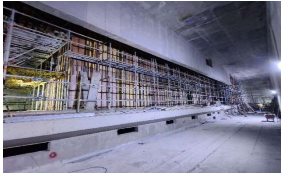
信義線東延段工程 R03 站軌道層月台施工現況
