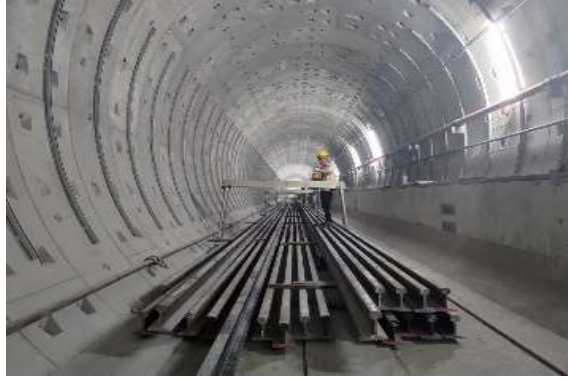
萬大線第一期隧道軌道 CQ811 標施工現況
