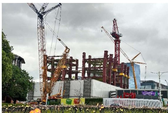
D1 基地鋼骨結構吊裝施作
