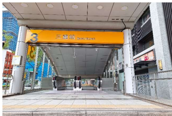
三重站電扶梯完成現況
