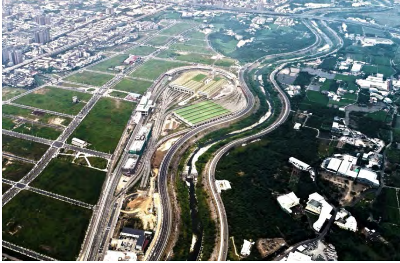
圖：臺中捷運烏日文心北屯線機廠現況鳥瞰
