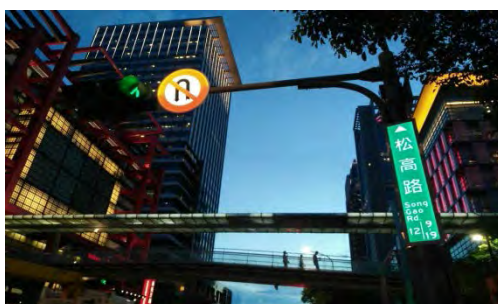
圖：標誌改內照式標誌
