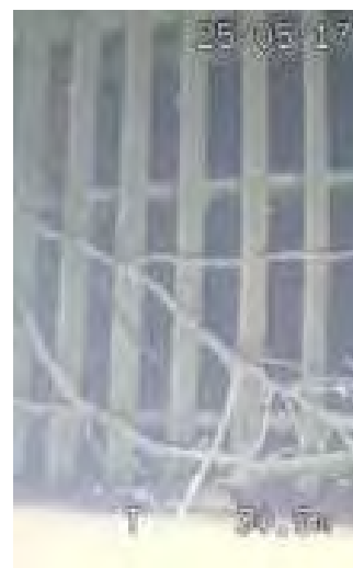
圖：106 年 7 月 5 日辦理發電進水口閘門 ROV 水下檢查
