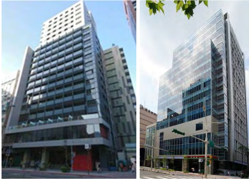
圖：捷運中山站捷 1(左)、捷 2(右)聯合開發大樓
