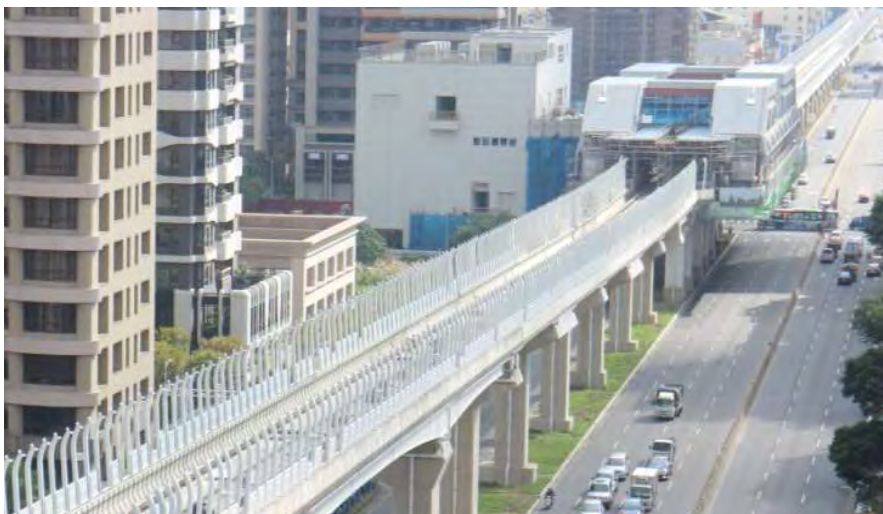
圖：捷運環狀線 Y18 車站出入口施工現況
