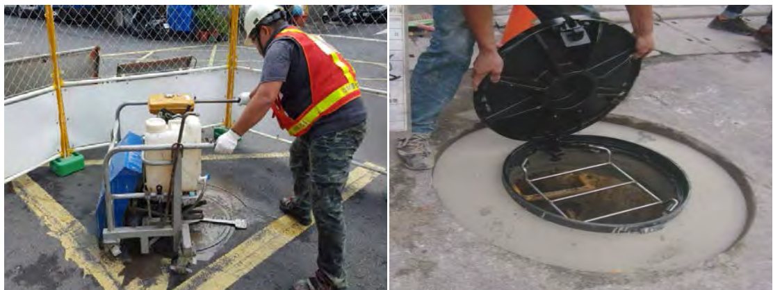
圖：耐揚壓人孔框蓋更新成果
