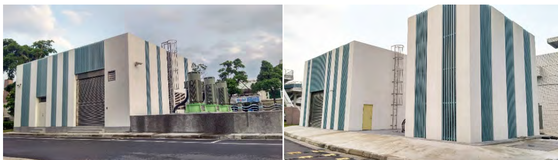
圖：迪化緊急進流抽水站新建工程(左)，迪化污水處理廠增設放流管工程(右)
