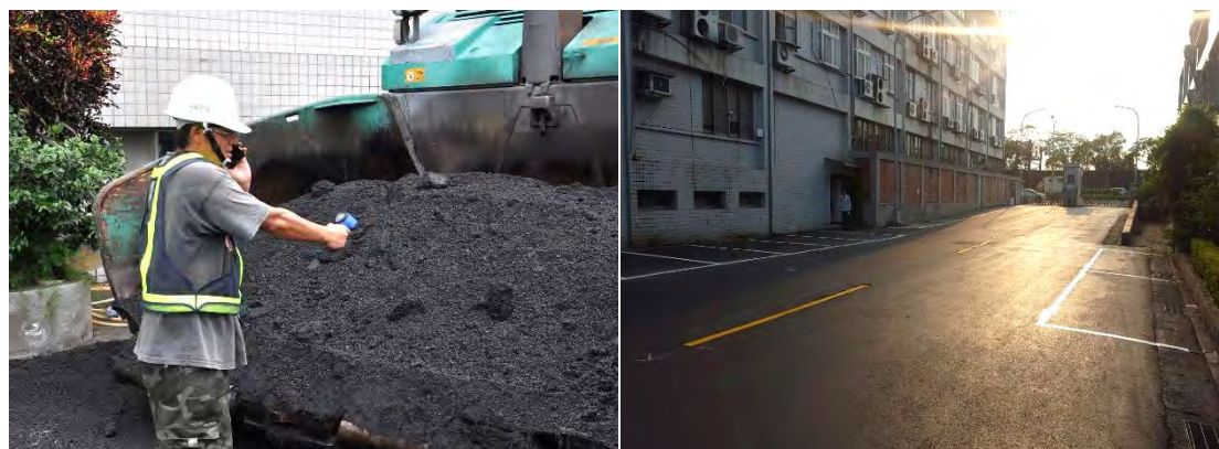
圖：乾燥汗泥與垃圾混燒產生的焚化底渣再生粒料(左)、內湖汗水處理廠的廠區道路更新工作成果(右)
