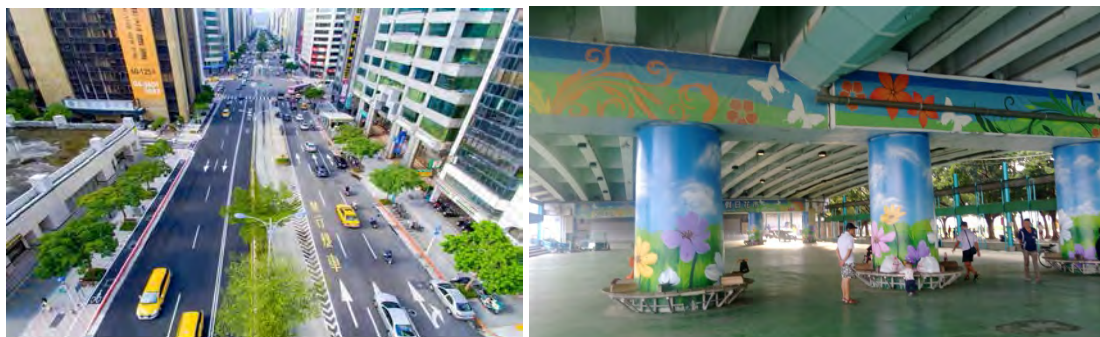
圖：松江路人行道拓寬松江南京路口(左)福和橋耐震墩柱鋼板包覆及橋下空間美化(右)
