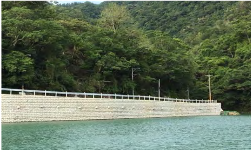
圖：水庫水域之灣潭產業道路下邊坡整治
