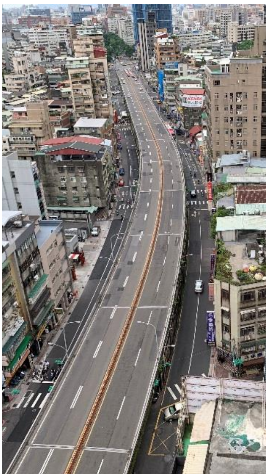
圖 17 重慶高架橋前現況
