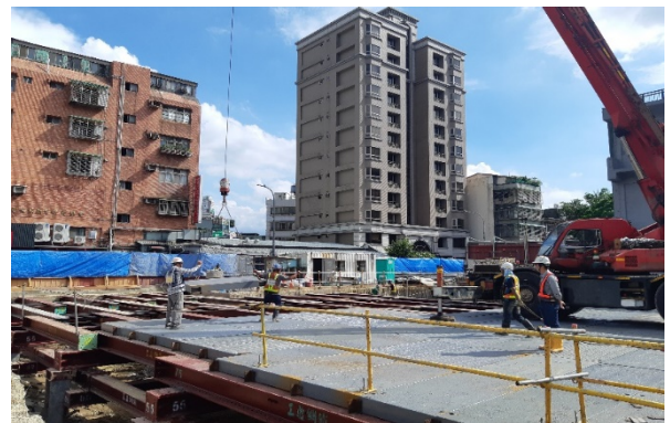
(照片 8)東園國小共構大樓施工現 況
