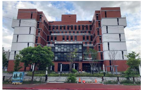
(照片 6)北投奇岩長青樂活大樓新 建工程現況
