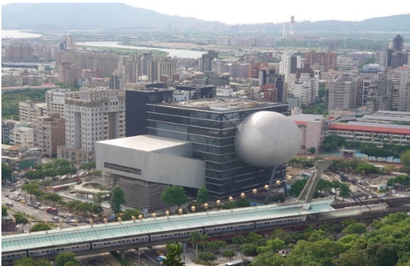
(照片 5)臺北藝術中心興建工程現 況
