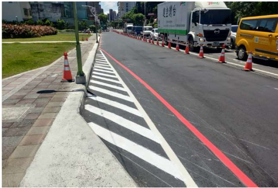
(照片 7)萬大線第二期 CQ890 區段 標人行道削減施工現況
