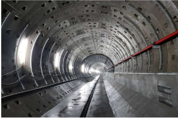
(照片 1) 萬大線第一期 CQ840 區段 標潛盾隧道完成現況
