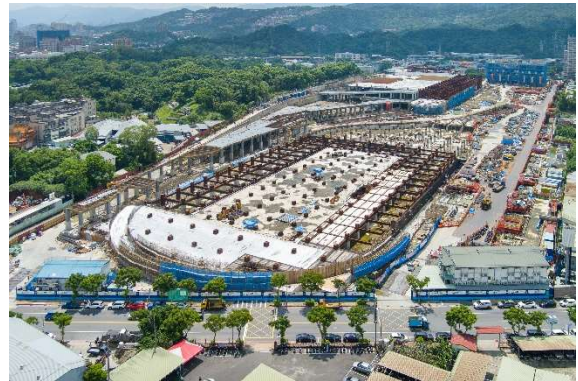
(照片 2) 萬大線第一期 CQ870 區段 標金城機廠施工現況
