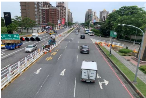
(照片 5) 環狀線北環段 CF680B 區 段標-Y23 站中央分隔島 削減施工現況
