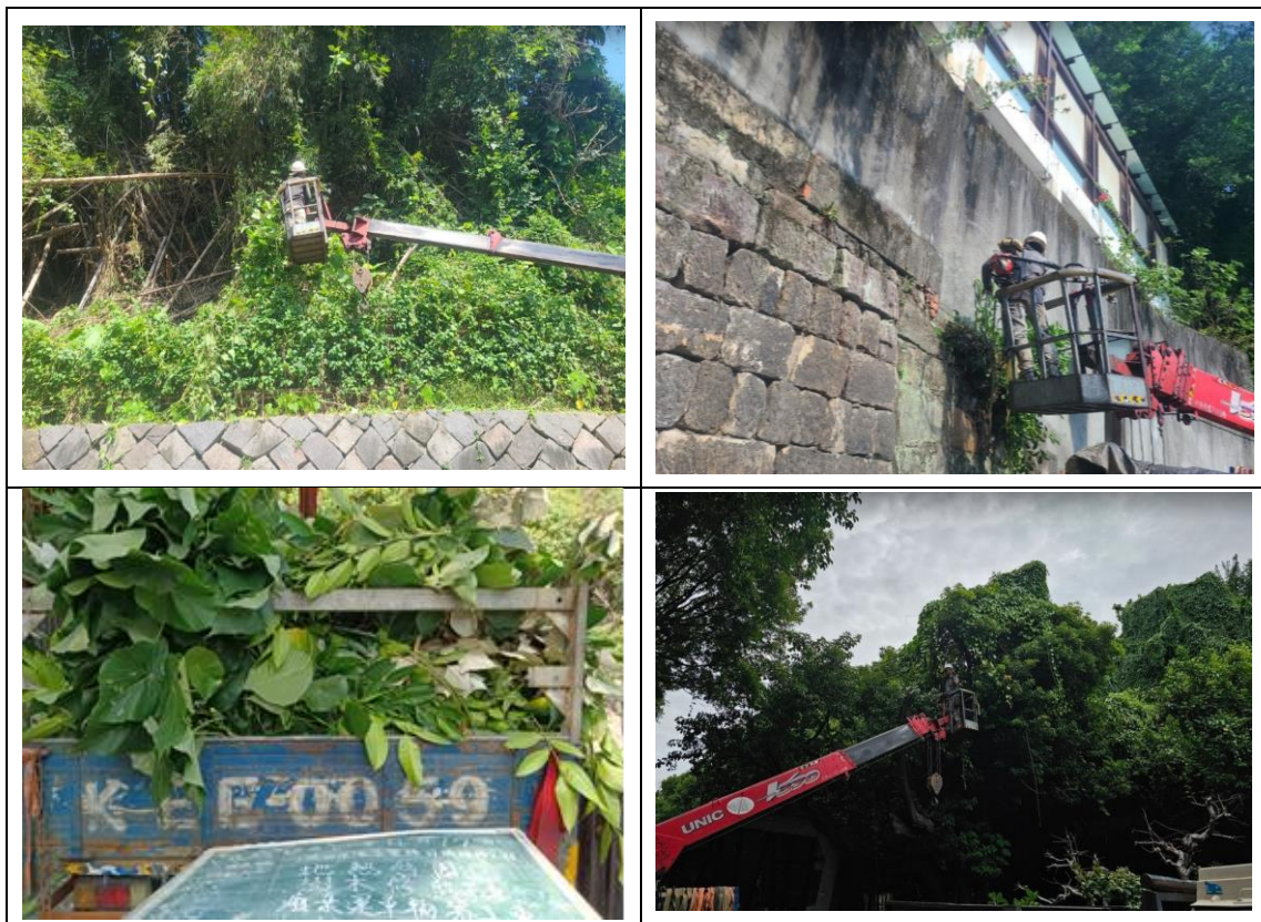
圖 3-1 清理倒塌樹木及周圍環境整理
