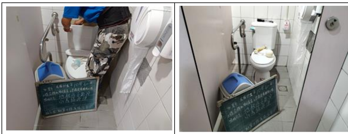
圖 3-6 地熱谷公廁馬桶修繕
