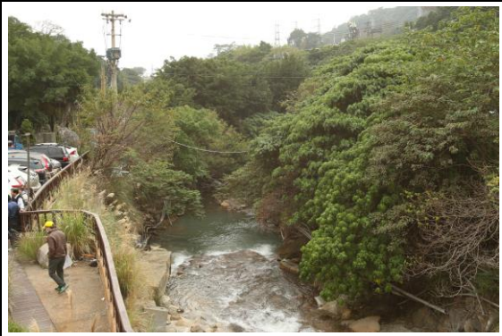
礮溪堤岸之一：第 2 樣區中游段堤岸現況。左側溫泉會館區有栽植多種園藝植栽。
