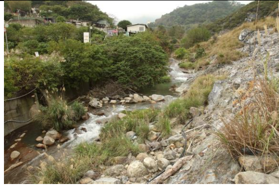
礮溪堤岸之一：第 1 樣區段堤岸現況。有岸為溫泉露頭，左岸則溫泉會館，會館後方約 100m 即進入國家公園範圍。
