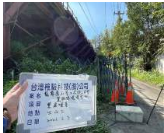
營建噪音(出水工)
