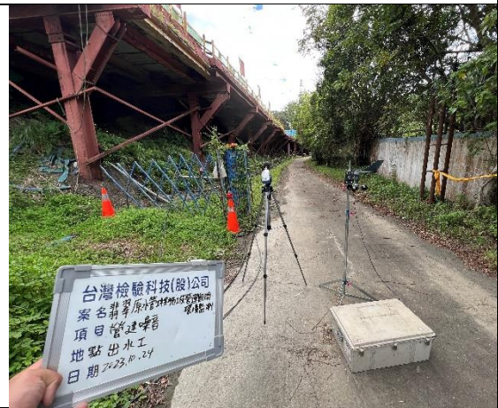
營建噪音(出水工)
