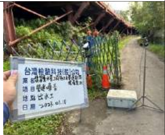
營建噪音(出水工)
