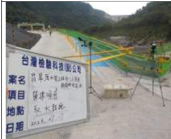
營建噪音(取水設施)
