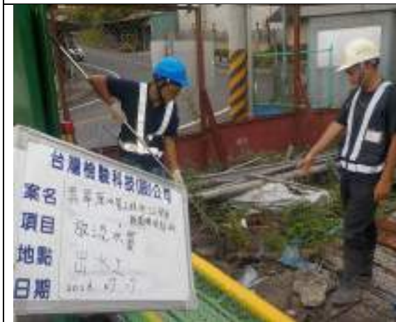
工區放流水(出水工)
