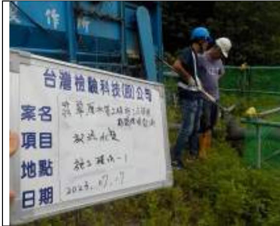
工區放流水(1號施工橫坑)
