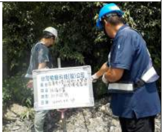
工區放流水(取水設施)
