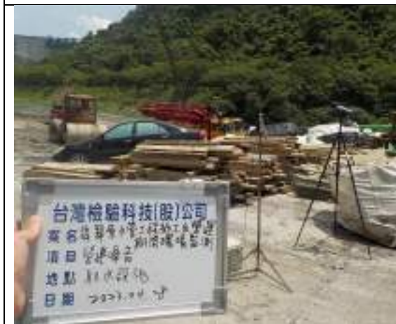
營建噪音(取水設施)
