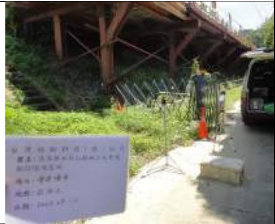
營建噪音(出水工)
