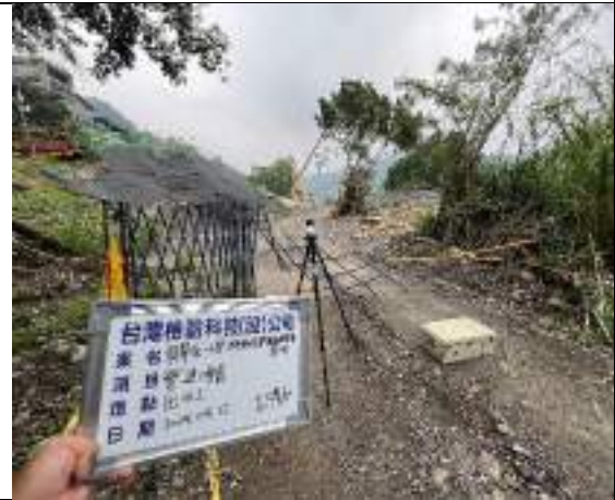
營建噪音(出水工)
