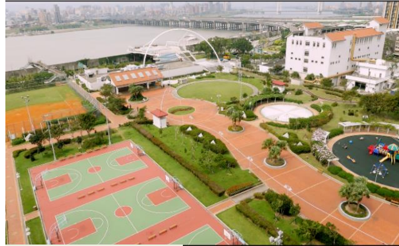
迪化污水處理廠
