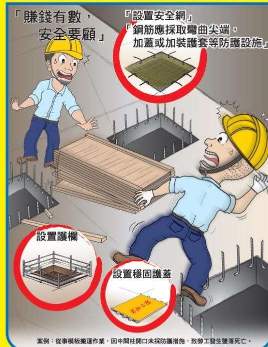
案例：從事模板搬運作業，因中間柱開口未採防護措施，致勞工發生墜落死亡。
