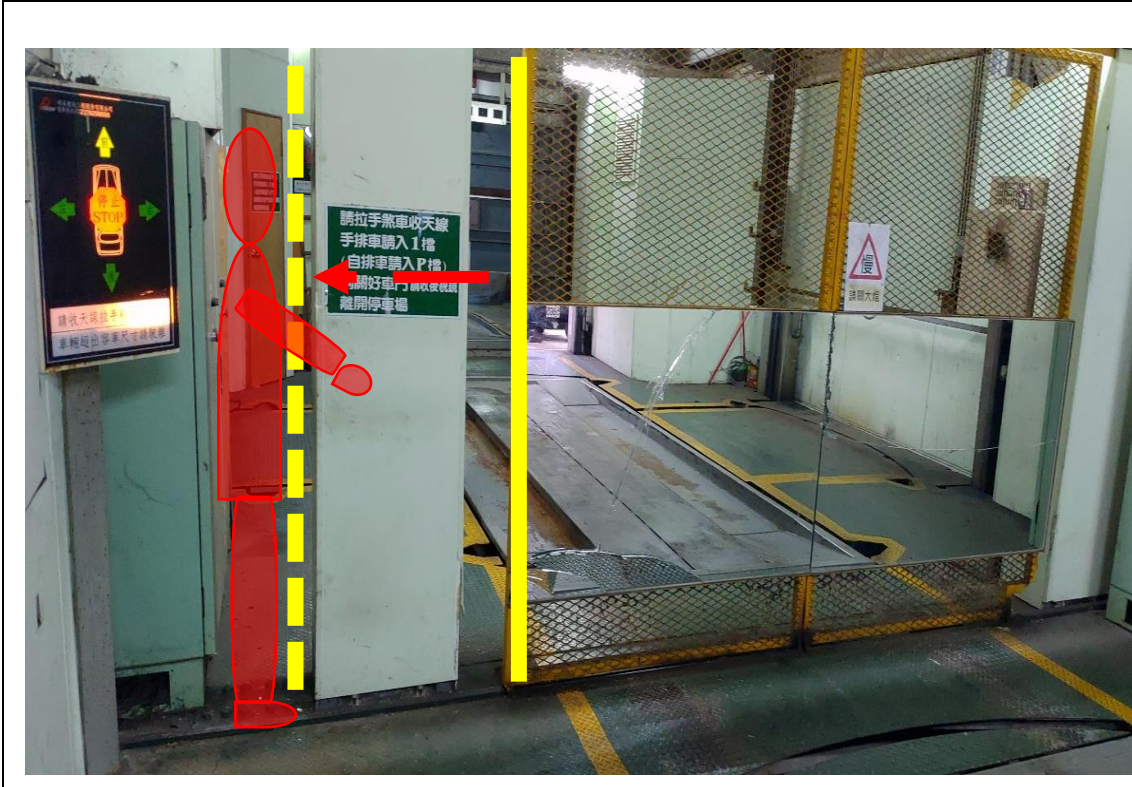
說明二 災害現場模擬示意畫面：罹災者側身進入維修通道被黃色閘門夾至牆壁。
