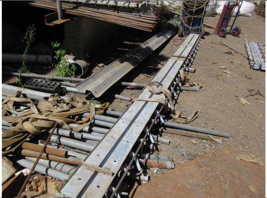
說明一 吊掛之角鋼伸縮縫(尺寸：5 公尺×0.23 公尺、重約 120 公斤)。
