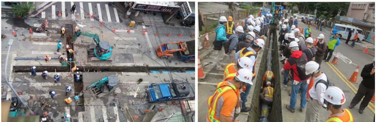
照片 2 NS 耐震管材現場施工
