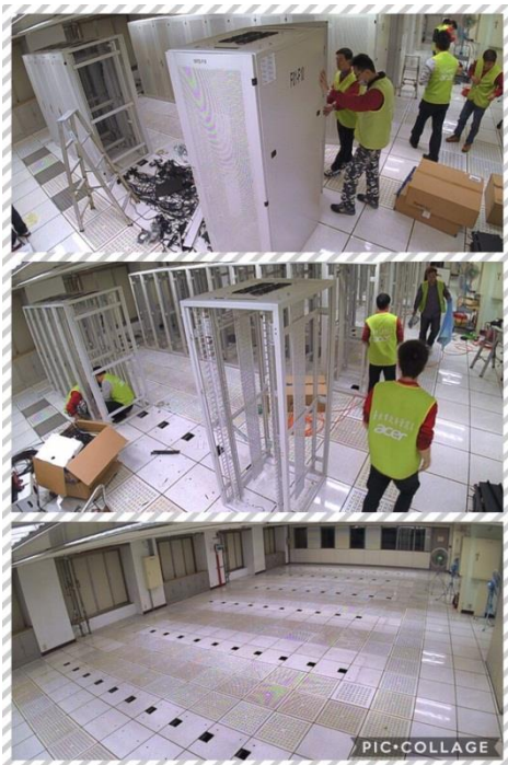
圖 26：市政大樓 10 樓東南區主機房已完成整併
