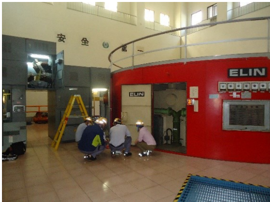
翡翠發電廠定期檢修作業
