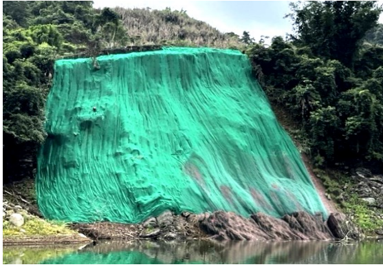
庫區邊坡抗沖蝕毯護坡工程
