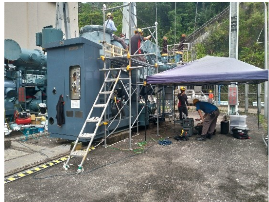
翡翠發電機組開關場匯流排更新
