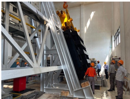
控水閘門檢測作業
