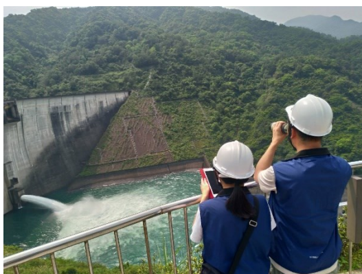
大壩及壩座邊坡現地巡檢
