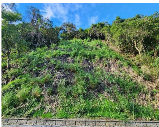
庫區道路邊坡改善
