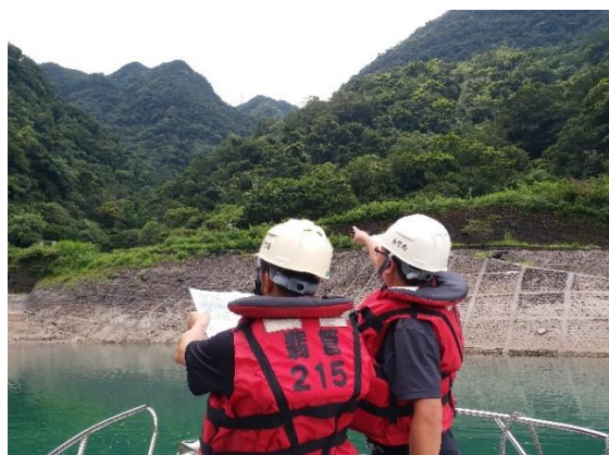
庫區水域邊坡定期巡檢
