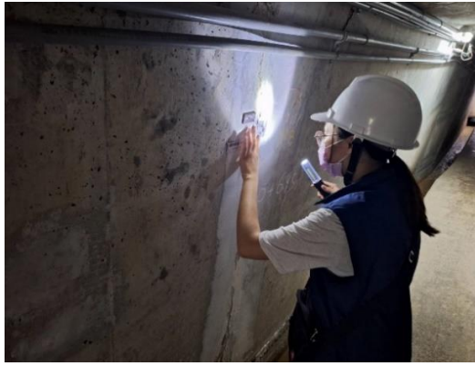
翡翠大壩內部廊道結構體巡檢
