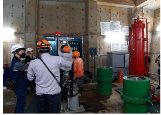
翡翠大壩放水閘門操作測試
