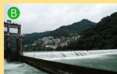
B 粗坑攔網 新店溪上游溪水，分送直潭堰及粗坑發電廠發電。
