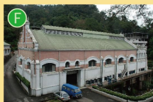
F 粗坑發電廠 於民國前三年完工，為臺灣最古老的發電廠，發電尾水送至青潭取水口，供自來水取用。
