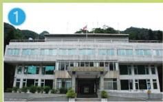
1 行政大樓 本局行政管理中心，執行大壩安全，水質維護及操作運轉、經營管理等水庫營運重要工作。
