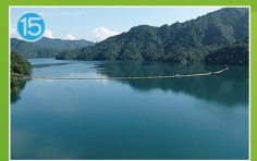
15 攔木浮柵 設置於大壩上游約400公尺處，其主要作用為攔截水庫內之漂流木屑與雜物，避免撞擊大壩與水工機械設施，確保大壩與水庫運轉操作安全。
