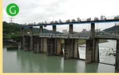
G 青潭堰 攔截粗坑發電廠尾水及新店溪溪水，供取水口取用後，剩餘水排入下游河川，維護河川生態。
