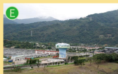
E 直潭淨水場 設備淨水能量每日340萬噸，為東南亞最大淨水場。
