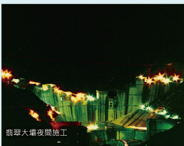
翡翠大壩夜間施工
