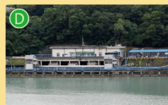
D 直潭取水口 取新店溪溪水，經原水幹線送至直潭淨水場處理。
