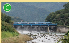
C 直潭攔網 新店溪溪水，以供直潭取水口取水，餘水再放流至青潭堰取用。
