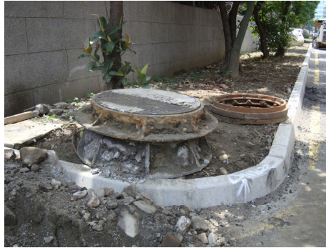
說明：路面完成情況。
