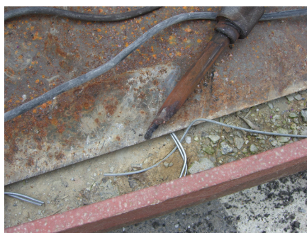
挖土機打除致電纜破損
