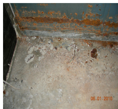
說明：台電受電室鐵門門口地上疑似拆除之鐵絲。
