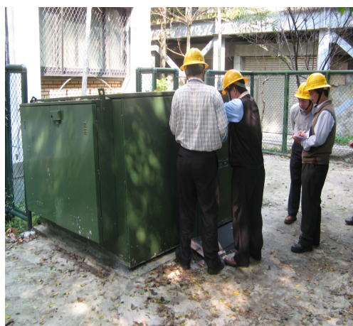
說明：模擬受傷勞工開啟配電設備（ATS）箱門。
