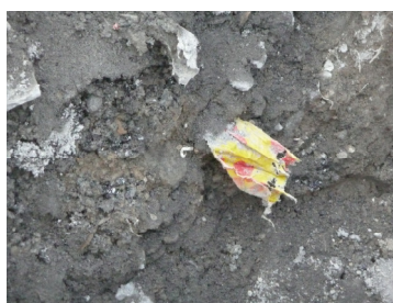
說明：電纜上方埋設之 警示帶。
