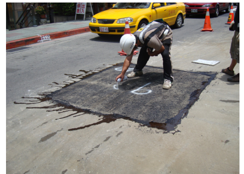
說明：現場人孔蓋情形。
