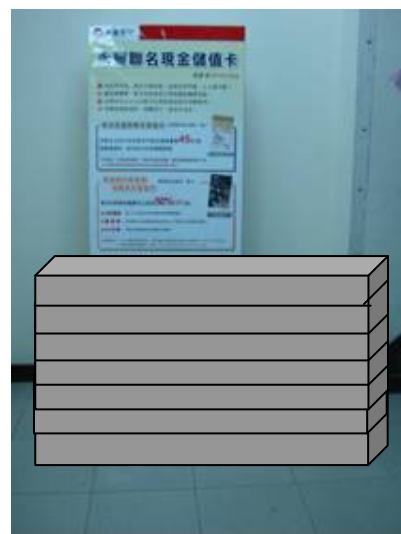
說明：板料應以水平方式堆積，以防止倒塌災害發生。
