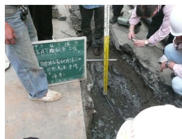
說明：電纜埋設之現況。
