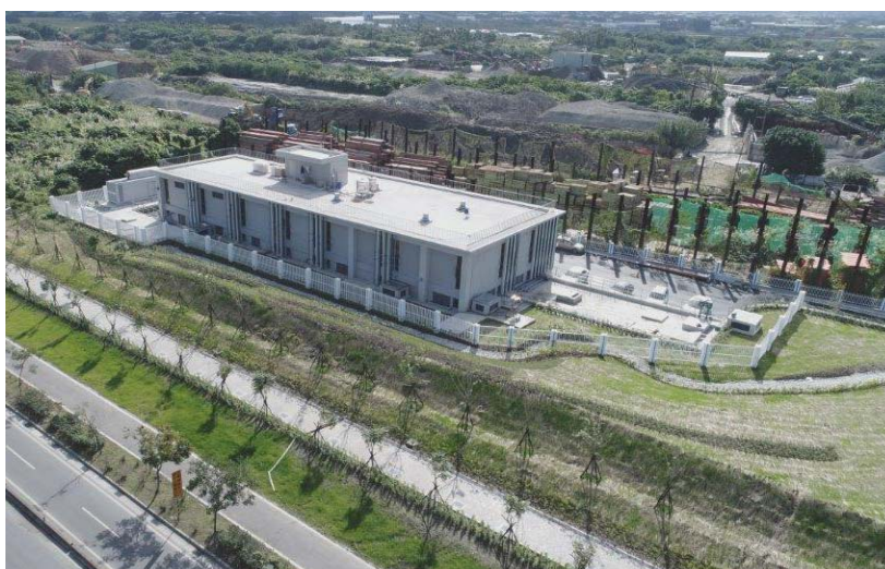
▲大度配水池暨加壓站新建工程
