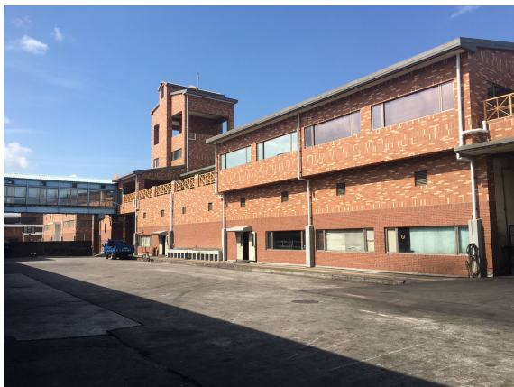
內湖修理廠現況照片：
