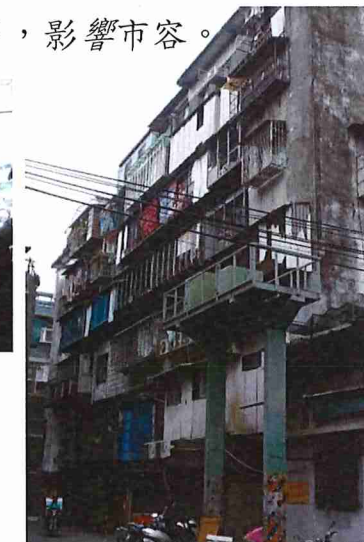
變電箱於民宅過近
