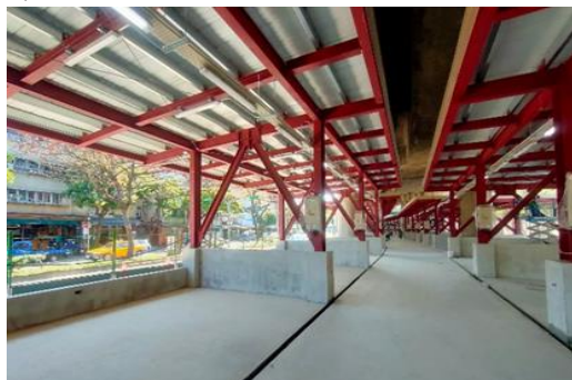
農中繼基地外環快橋下施工現況
