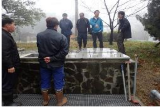
中山樓取供事業施工情形
