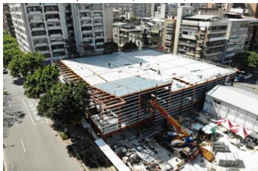
成功中繼市場施工現況
