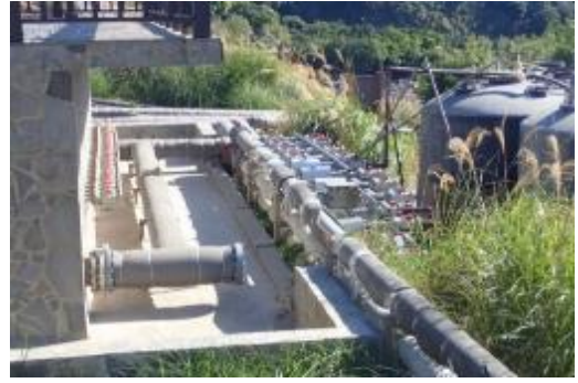
行義路取供事業施工情形
