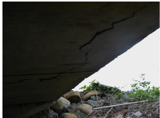
20. 橋面板 (腐蝕裂縫)
