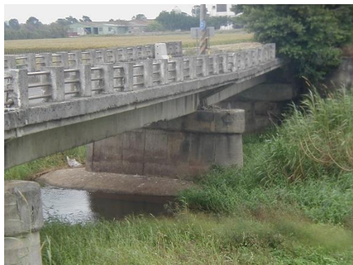
12. 橋墩保護設施 14. 橋墩墩體
