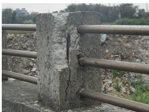
11. 護欄 (鋼筋腐蝕外露)
