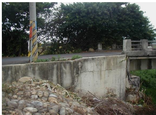
5. 橋台基礎 6. 橋台 7. 翼牆/擋土牆
