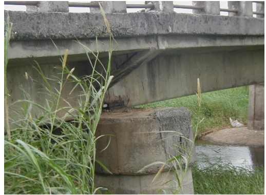
18. 主構件-1 (承壓破壞)
