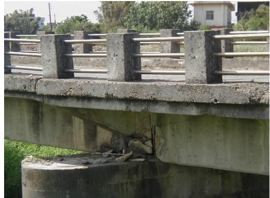
18. 主構件-1 (承壓破壞)
