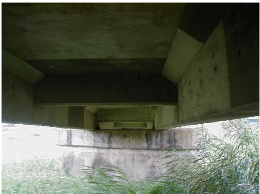
19. 副構件 (隔梁良好) 16. 止震塊
