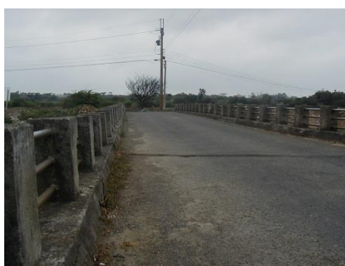
11. 護欄 (鋼筋腐蝕外露)
