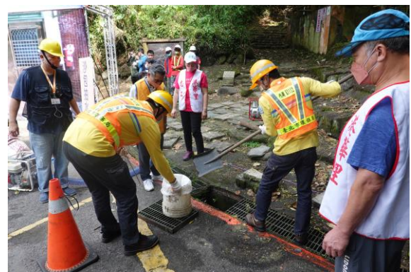
說明：發現垃圾及落葉堵塞水溝，里鄰應變小組通報內湖區清潔隊協助排除
