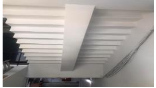
中山商場樓梯間粉刷
