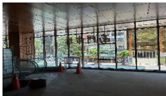
南門市場內部施工現況
