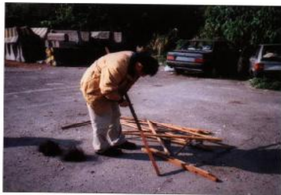
■ 建設局人員正拆除鳥網及其支架。
