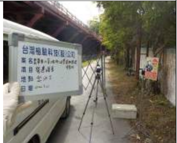
營建噪音(出水工)
