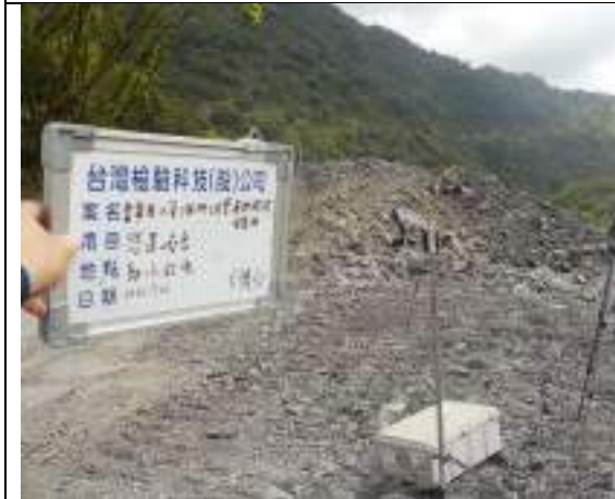
營建噪音(取水設施)
