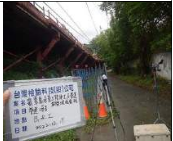
營建噪音(出水工)
