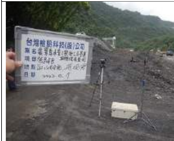
營建噪音(取水設施)
