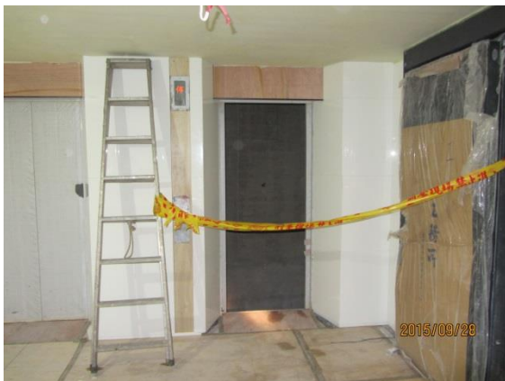
說明：新建工程開啟升降機乘場門。
