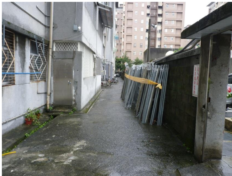
說明：整頓完成後之工地現場。
