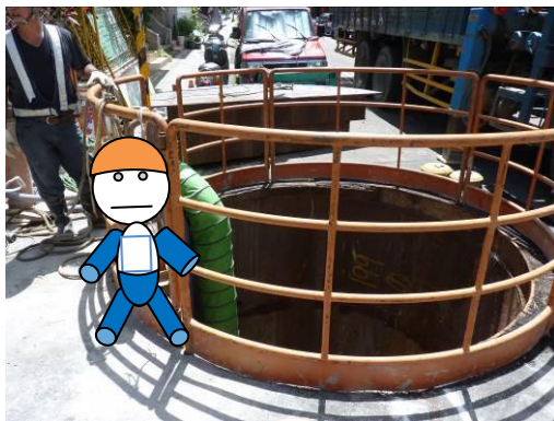
說明：罹災者自工作井護欄安全門處墜落至工作井內。
