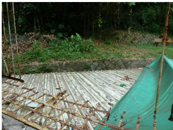
說明：現場施工現況。
