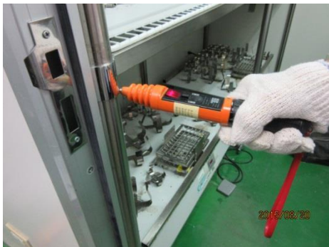
說明：職災現場感電模擬測試。
