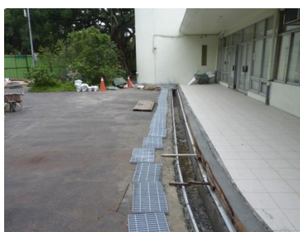
說明：水溝蓋切割之施工現場。
