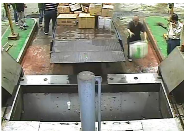
說明：勞工丟擲廢棄物至傾卸口的錄影畫面。 （垃圾焚化廠提供）
