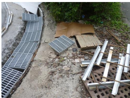
說明：水溝蓋切割之施工現場。
