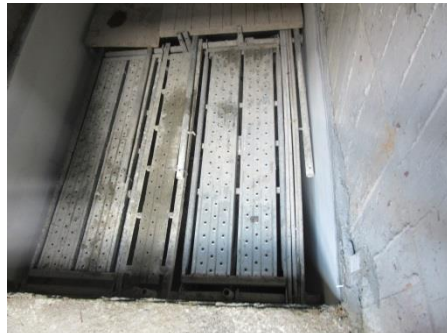
說明：勞工有遭受墜落危險之虞者，應於該處設置護欄、護蓋或安全網等防護設備。
