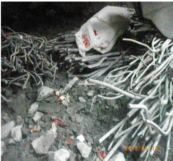
說明：災害現場鋼筋堆鋼筋未彎曲尖端
