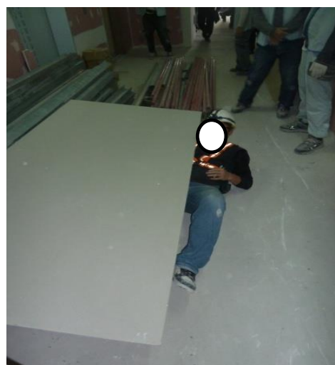
說明：石膏板因外力導致倒塌，造成罹災者右半身被石膏板壓住(現場模擬照
