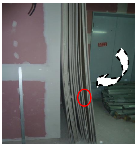
說明：石膏板直立於插座前(現場模擬照片)
