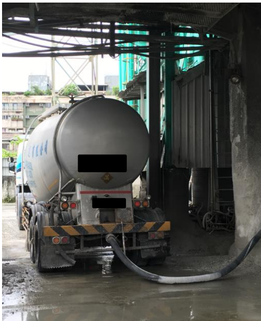
說明：現場照片（非發生事故之車輛）。
