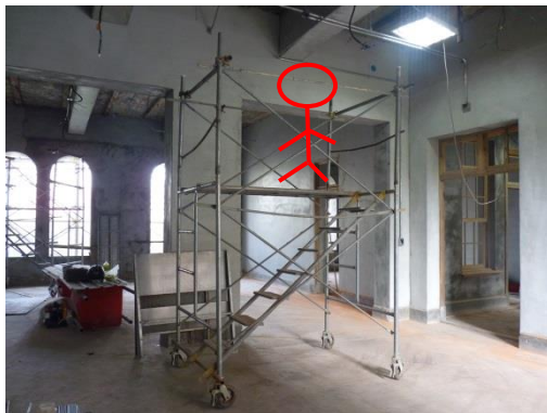
說明：賴員於施工架上進行水電配線作業。
