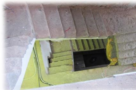
說明：樓梯開口俯視圖。
