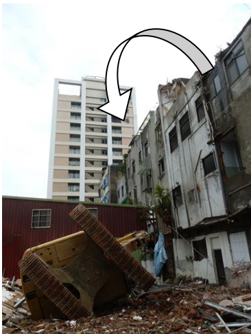
說明：大鋼牙重機械自4樓頂板墜落至1樓地面。
