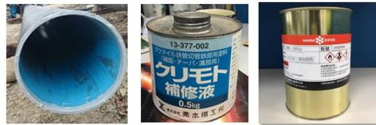
圖 10 切管斷面塗上修補液
